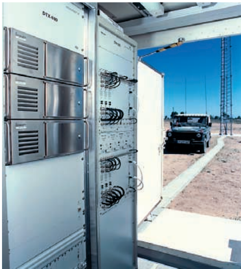
BILD 7 Die TETRA-Basisstation DTX-500.
