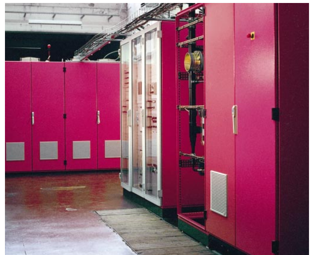
BILD 4 75-kW-Klystronverstärkeranlage (500 MHz) für physikalisch-technische Anwendungen.
