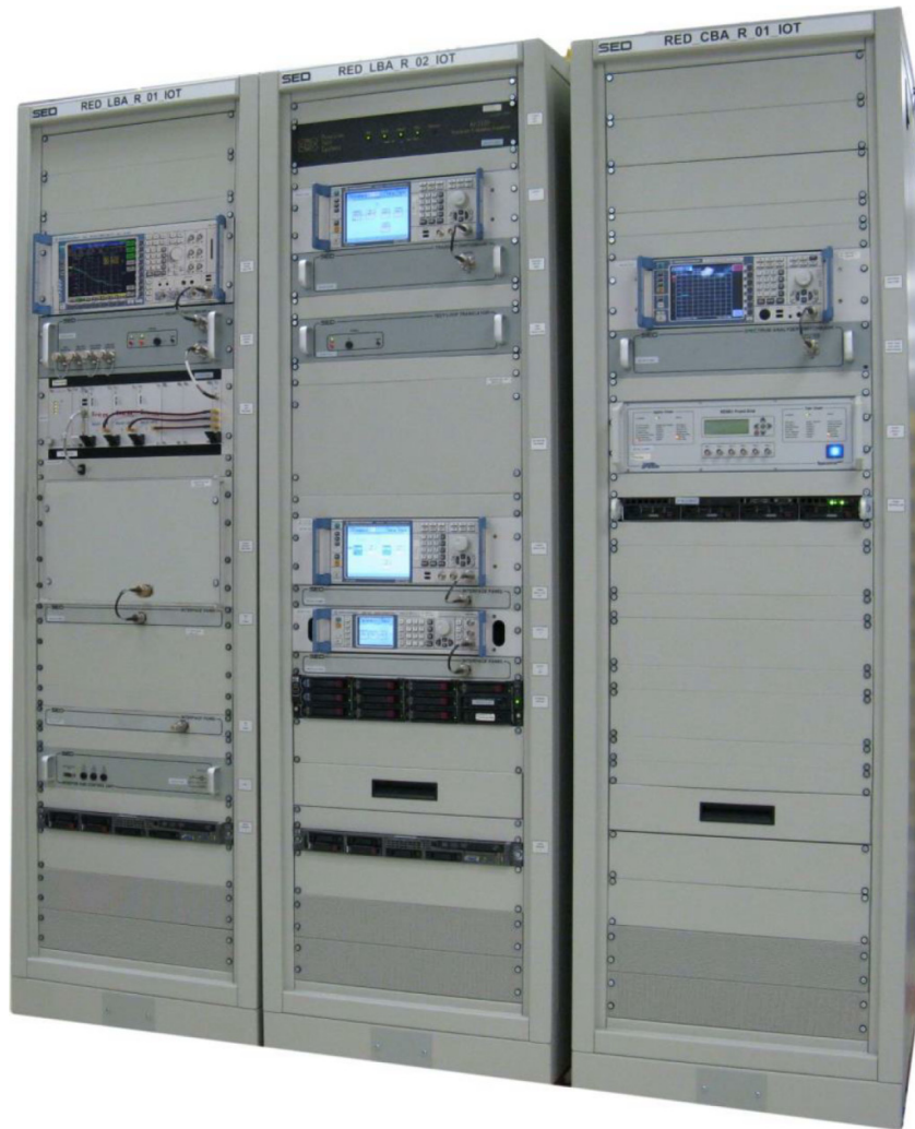
図6-1: ローデ・シュワルツのテスト機器を使用した自動テストシステム(SED Systems提供)
